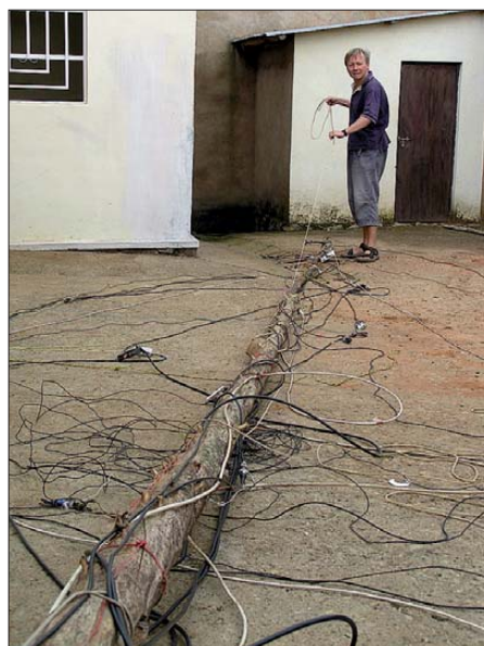
9U0VB bei der Demontage der Koaxialkabel-Dipole in Burundi.
