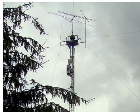
Der Antennenmast von DB0ZWI: Höhe 20 m und mit einer Arbeitsbühne befahrbar. Am Mast, in 5 m Höhe, ist die komplette Stromversorgung des Digipeaters, die durch ein Schaltnetzteil 230 V/12 V (80 A) realisiert ist, angebracht. In 18 m Höhe befindet sich der Schrank für die Linktransceiver sowie den Transceiver für die WLAN-Verbindung zur Hochschule in Zwickau. Foto: DB0ZWI
