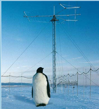
Die Aufnahme zeigt die Log-Periodic-Richtantenne Rohde & Schwarz AK471, die von 1992 bis 1994 an der Antarktisforschungsstation Neumayer II für den Kurzwellenfunkverkehr verwendet wurde, zusammen mit einem „neugierigen“ Kaiserpinguin. Foto: Dr. Volker Strecke, DL8JDX
