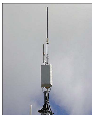
Die D-STAR-Relaisfunkstelle HB9BO samt Antennenanlage auf dem Schilthorn, JN36WN Foto: HB9BO
